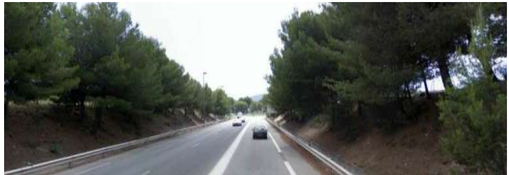
Entrée Nord, depuis la sortie d'autoroute
